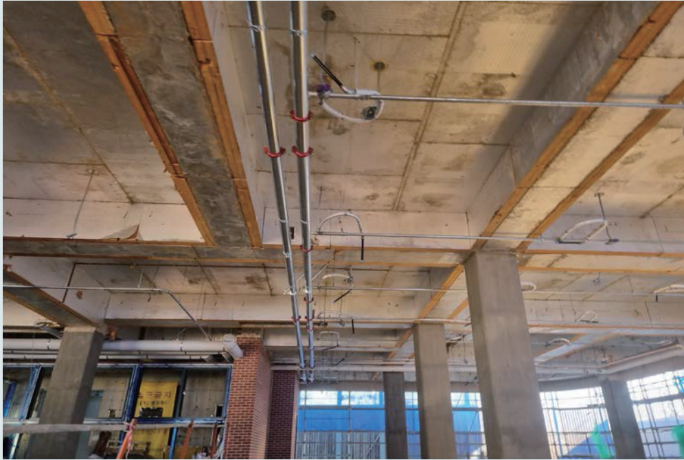
칠보중학교 다목적 체육관동 주차장 스프링클러 배관공사
