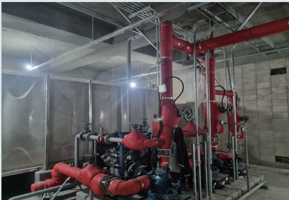
칠보중학교 다목적 체육관동 펌프실 배관공사
