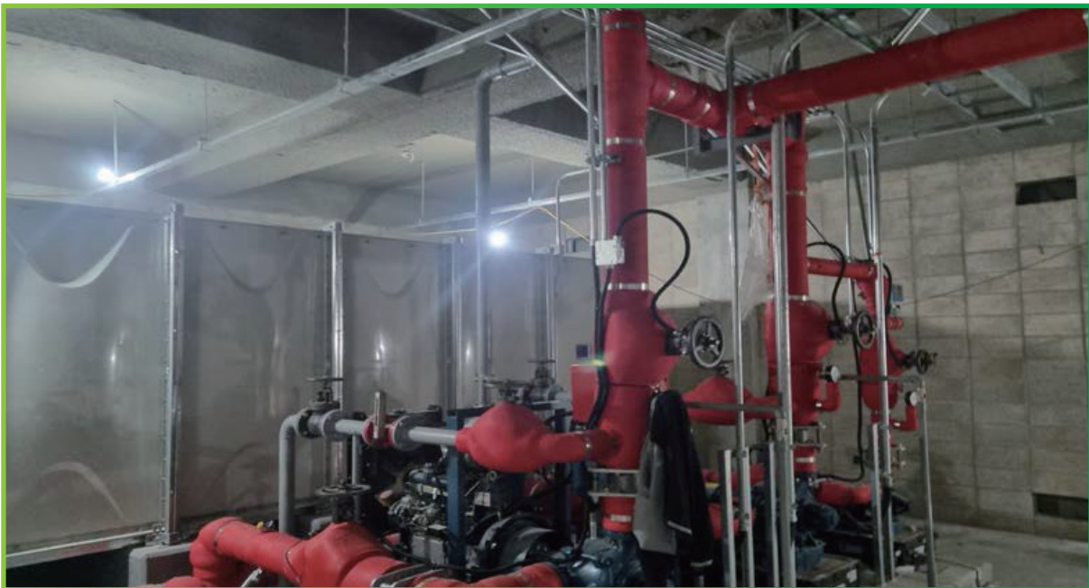
칠보중학교 다목적 체육관동 펌프실 배관공사
