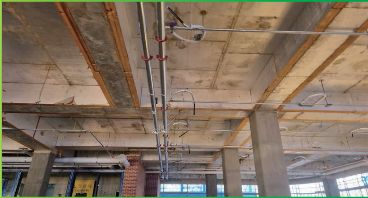
칠보중학교 다목적 체육관동 주차장 스프링클러 배관공사
